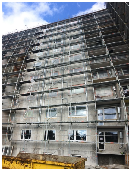
Joonis 5. Ventilatsiooni sissepuhketorustik paigaldatakse fassaadile soojustuskihi sisse nii tavapärasel kui ka tehaselisel renoveerimisel.
