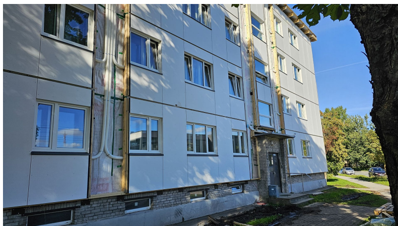
Joonis 5. Ventilatsiooni sissepuhketorustik paigaldatakse fassaadile soojustuskihi sisse nii tavapärasel kui ka tehaselisel renoveerimisel.
